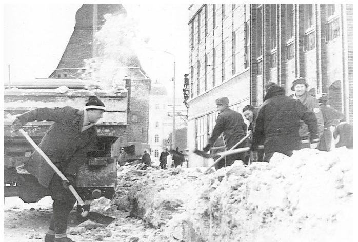
Räumungsarbeiten nahe des Steintors. Foto: Stadtarchiv Rostock
