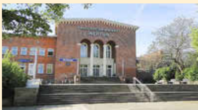
Hallenschwimmbad „Neptun“ Foto: Arndt Draheim, KOE
