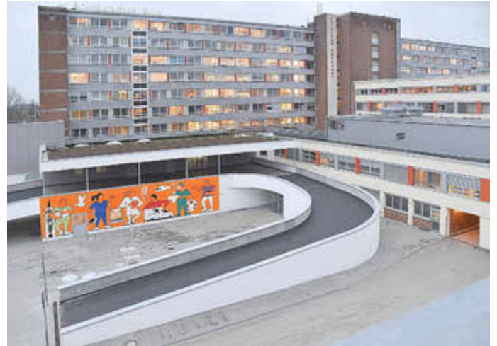
Blick auf die Auffahrt.
