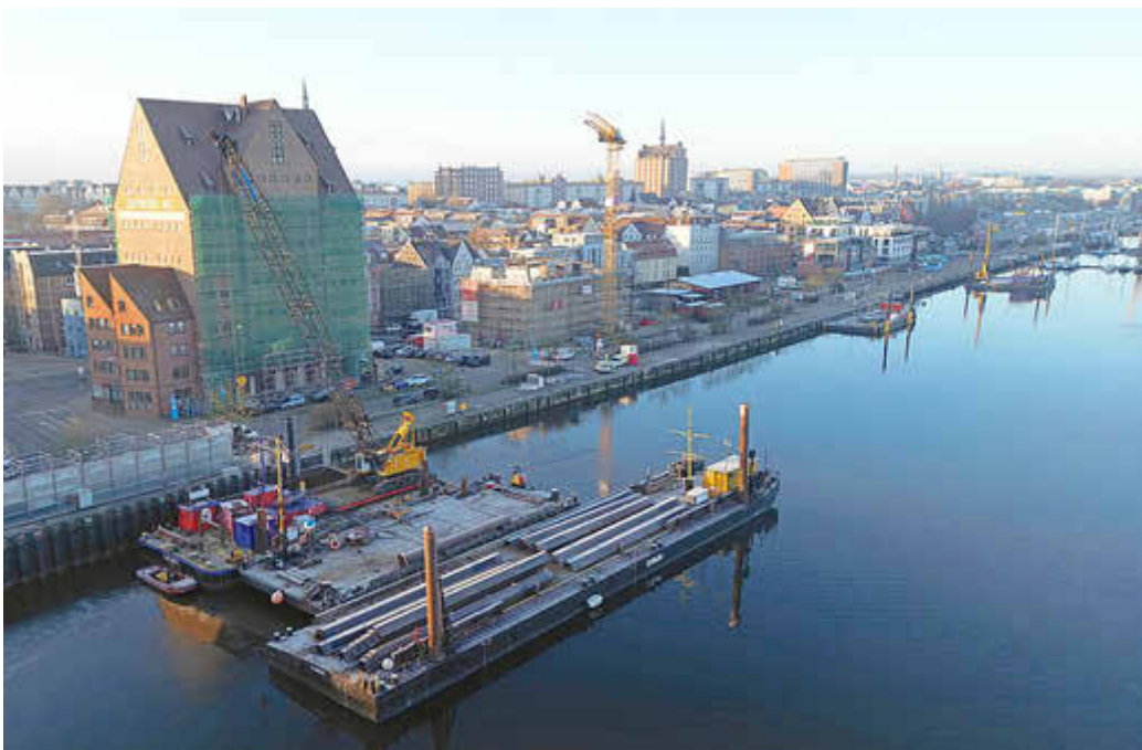
Das Kempowski-Ufer wird grundhaft instandgesetzt.
