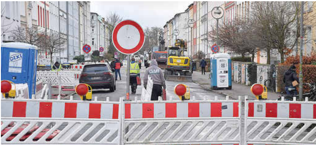
Blick auf die Bauarbeiten in der Fritz-Reuter-Straße.
