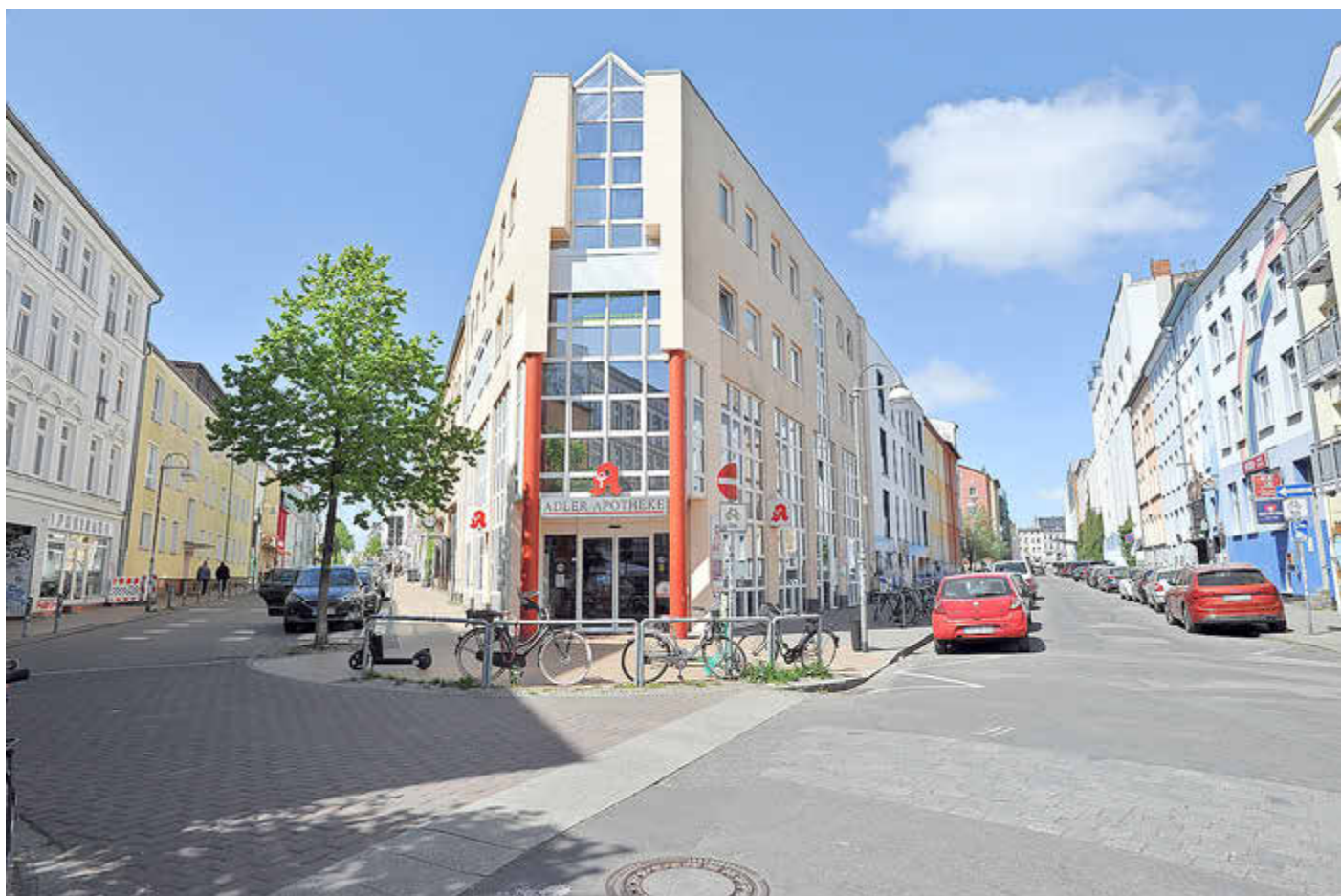
Am 3. Juni wird der Brink wieder als „Sommerstraße“ eingerichtet. Perspektivisch soll der Straßenraum baulich neu gestaltet werden. Wie wird in den nächsten Jahren erarbeitet.
