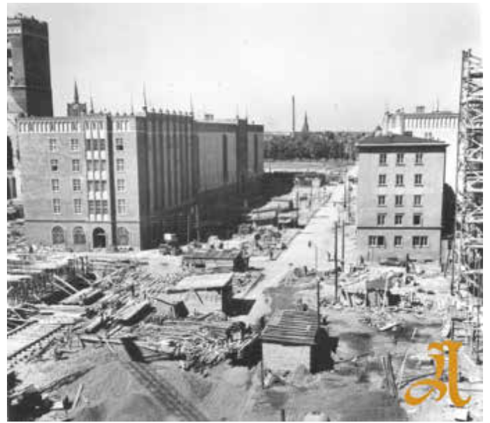
Bau- und Abrissarbeiten in der Langen Straße (ca. 1953)
