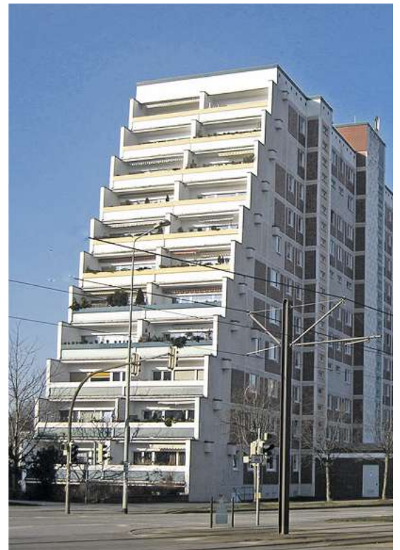
Das originelle Terrassen-Hochhaus in Evershagen.
