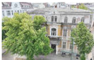
Ehemaliges Drostenamt, Wismarsche Straße 8
