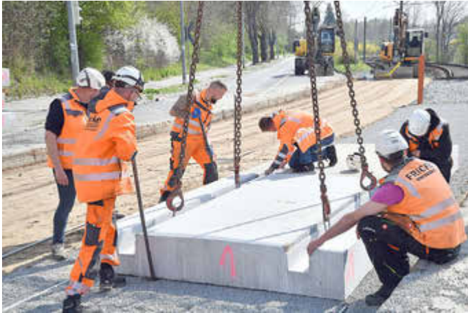
Solche Gleistragplatten werden verbaut. Foto: Joachim Klook
