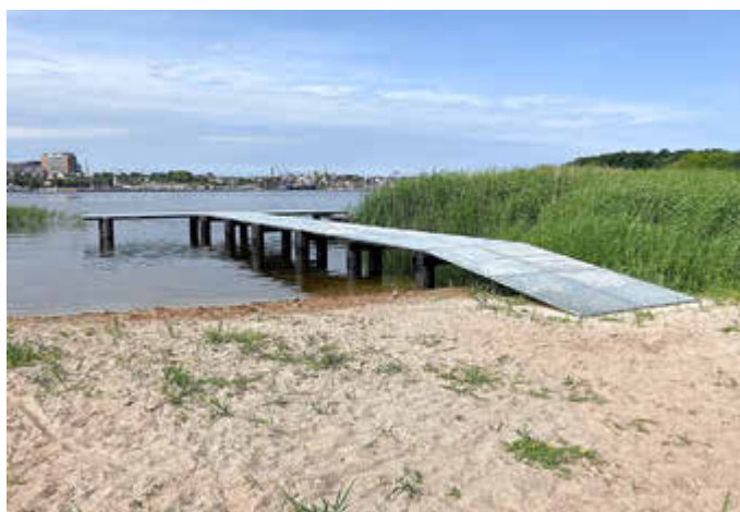
Der neue Steg am Gehlsdorfer Ufer ist dank des verwendeten Materials langlebig und benutzerfreundlich. Foto: Hafen- und Seemannsamt
