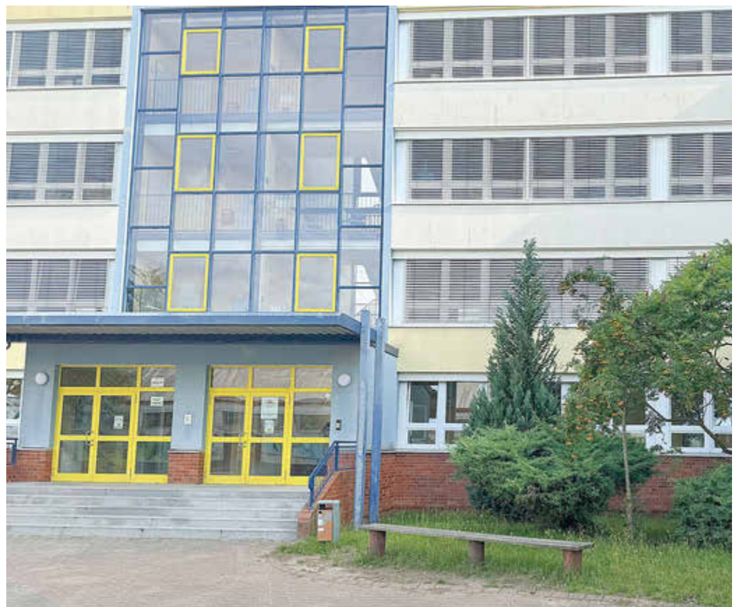
An der Kooperativen Gesamtschule Südstadt (KGS) werden Fassaden saniert.
