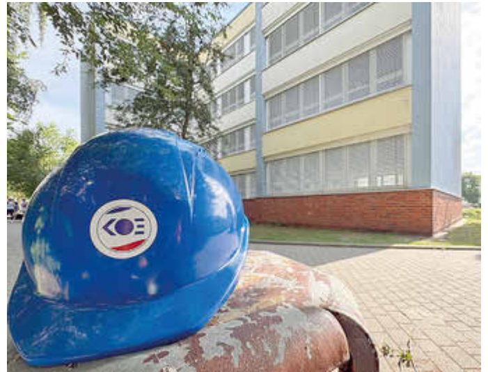
Ferienzeit ist Sanierungszeit. Der Eigenbetrieb KOE bringt ab 22. Juli insgesamt zwölf Objekte in der Stadt auf Vordermann.
