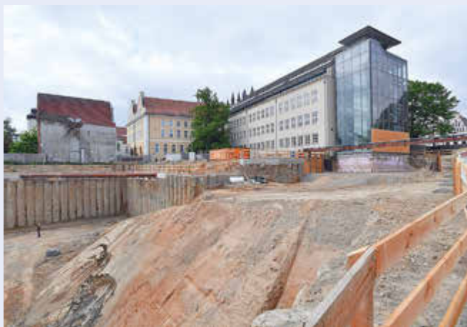
Blick auf die Baustelle am Tag der Städtebauförderung im Mai.
