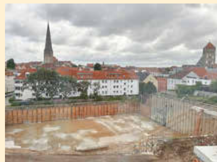
Hier entsteht der neue Rathausanbau.
