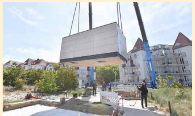
Zwei Kräne hoben die WC-Anlage über die Promenade.
