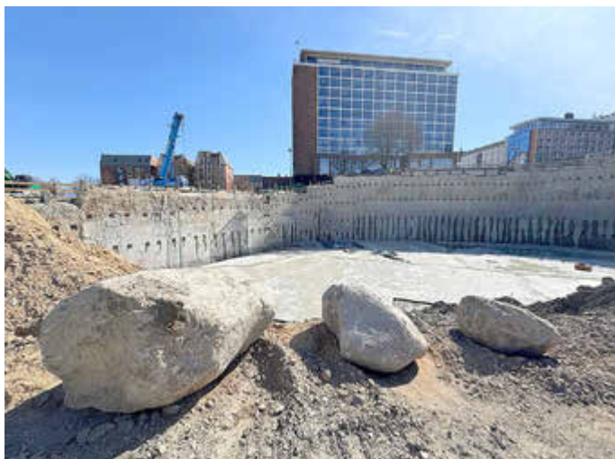
Blick in die Baugrube des künftigen Volkstheaters Foto: KOE
