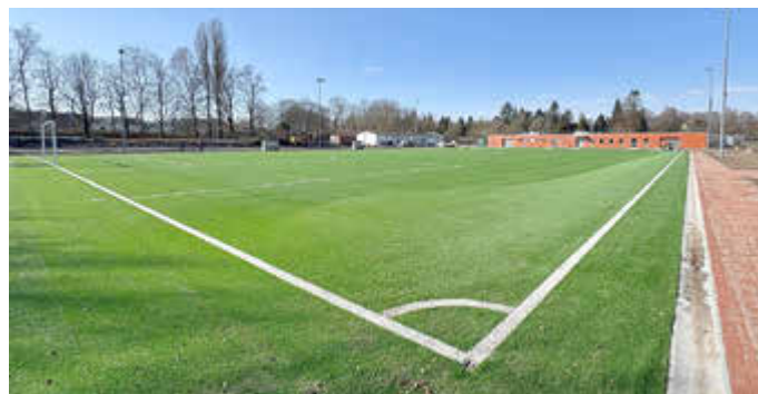
Für den neuen Kunstrasenplatz der Sportanlage „Rote Erde“ wurden mehr als 5.800 Quadratmeter Kunstrasen verlegt.
