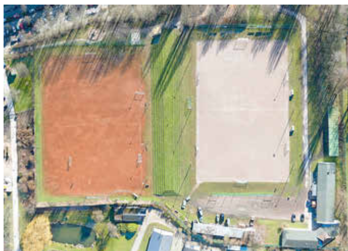
Blick auf die Sportanlage „Rote Erde“ im Sommer 2023. Der ehemalige Schotterplatz rechts ist mittlerweile modernem Kunstrasenbelag gewichen. Das Spielfeld links soll perspektivisch saniert werden. Fotos (3): KOE Rostock
