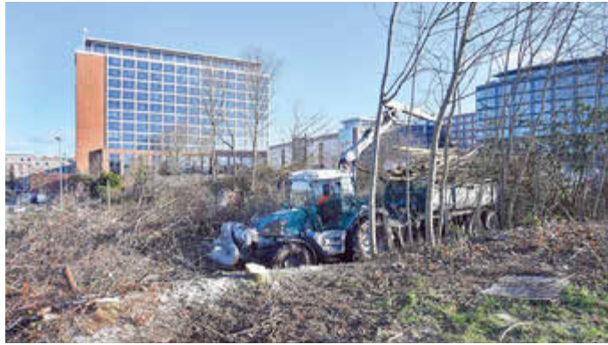
Die Arbeiten am Bussebart beginnen.
