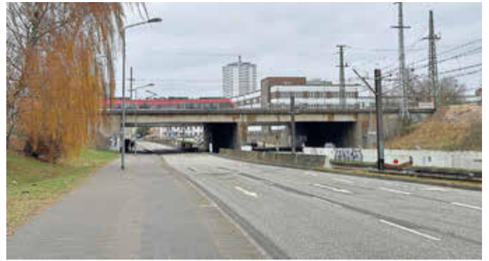
Goetheplatzbrücke aus Richtung Süden Ende Dezember 2023.
