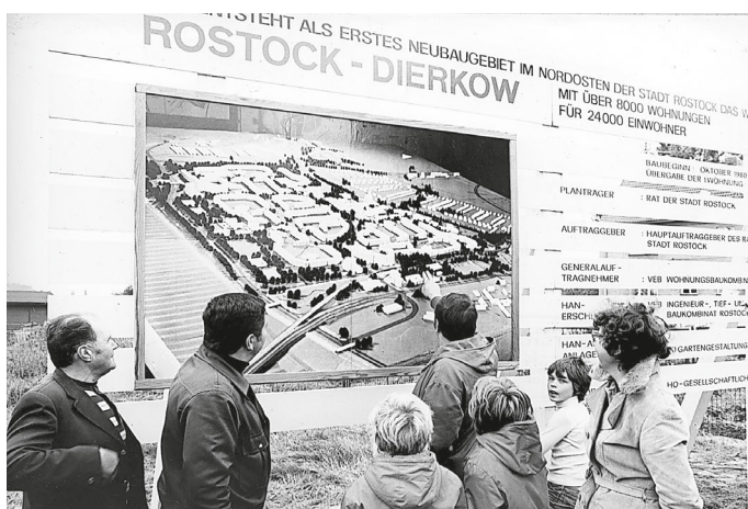
Baustart in Dierkow wird angekündigt.
