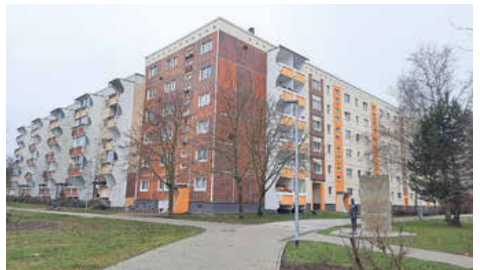
Längste Straße in Dierkow-Neu: der Kurt-Schumacher-Ring, der in der Anfangszeit des Viertels Allee der Bauschaffenden hieß.
