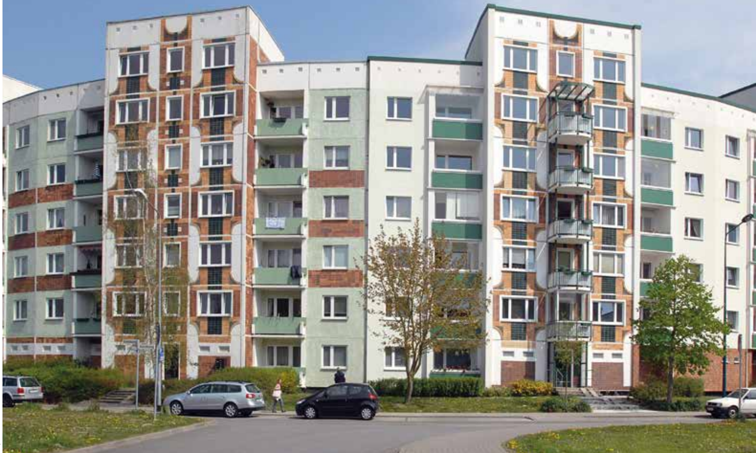
Nahezu alle Wohnhäuser, wie in Schmarl, wurden in den vergangenen Jahren umfassend modernisiert.
