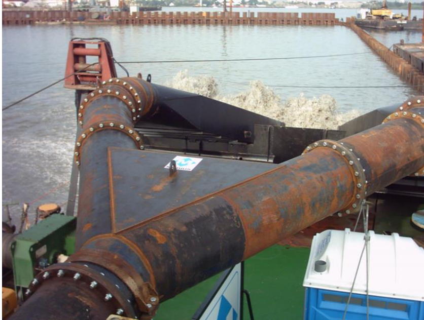
Abbildung 16: Verrieselung von Sand auf Weichschichten, Pier III, Seehafen Rostock
