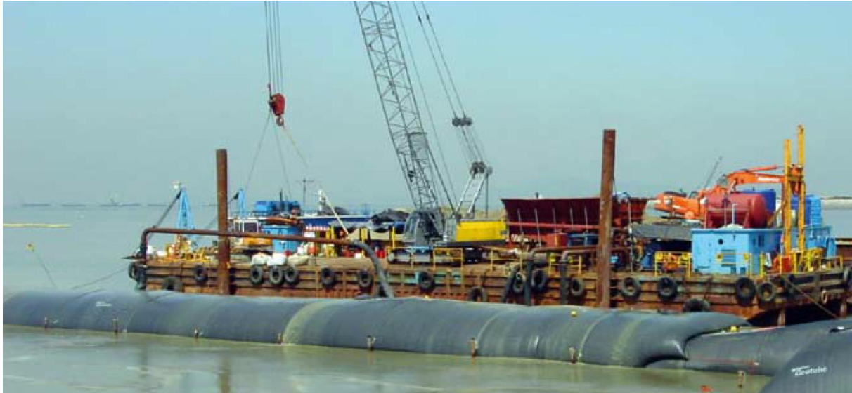
Abbildung 15: Geotube im Wasserbau
