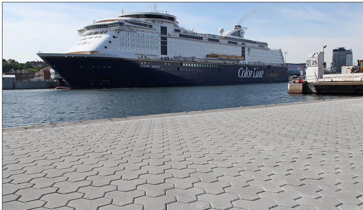
Abbildung 16: Beispiel – Pflasterbefestigung (Steintyp: Triloc)
