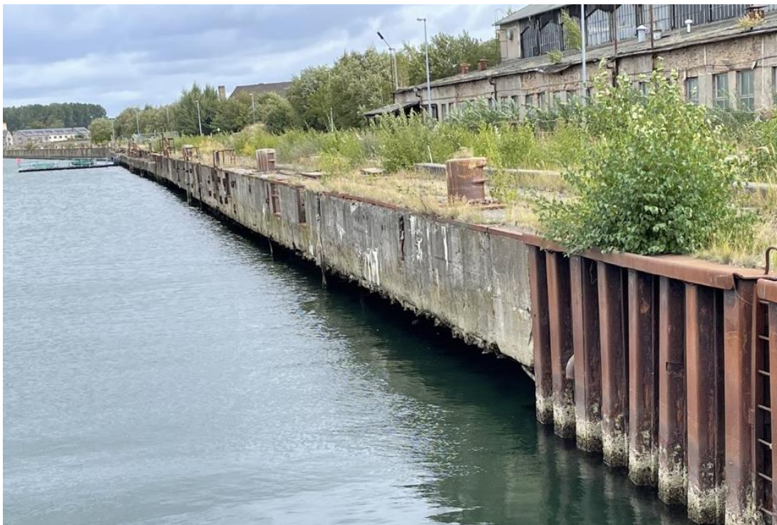
Abbildung 11: Frontansicht Bestand Kaisante Liegeplatz P11
